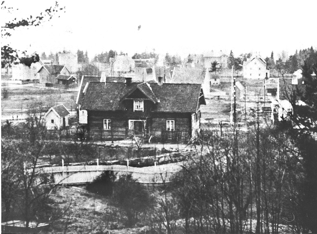
Øvre Holtet våningshus ved Ekebergveien der Skogroveien kommer ned.
