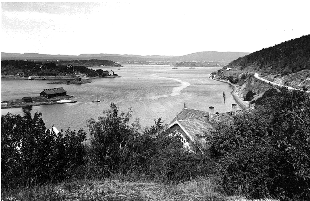
Foto fra Bekkelagskollen og nordover. Til venstre Kneppeskjær med stor bygning.
